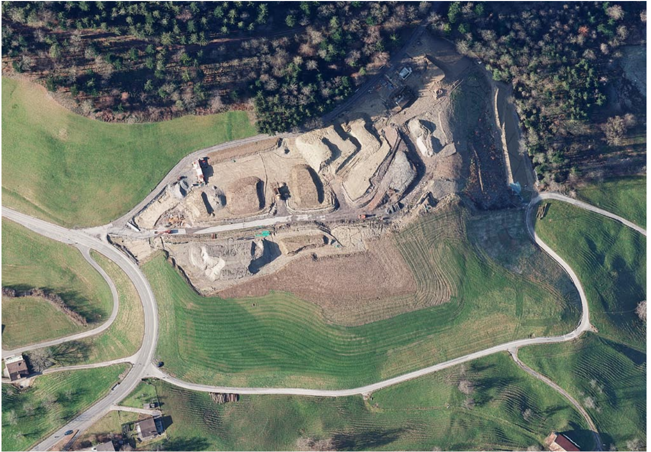
Sanierungsarbeiten bei der ehemaligen Deponie Baarburg (Flugbild vom 31.12.2012)
