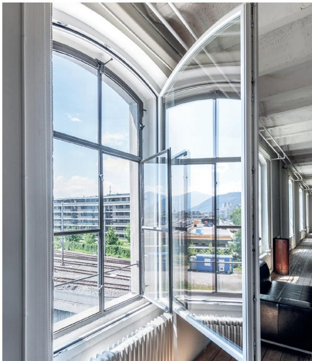
Industriebau in Zug. Gusseisenfenster aus dem 19. Jahrhundert und neue Fensterebene. Fotografie Regine Giesecke.
