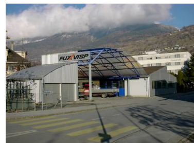
Unterstände Tiefe > 4.00 m
