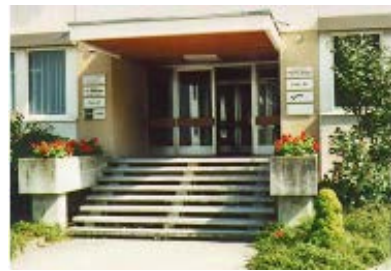
Wichtig / Eingang öffentl. Gebäude
