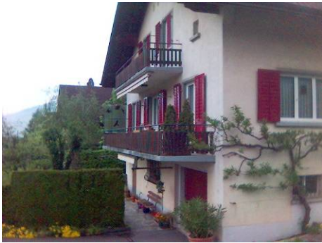
Balkone nicht erheben.
