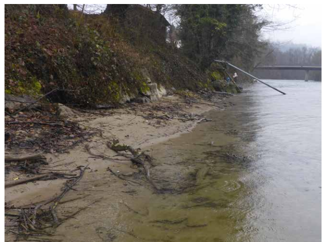
Locker befestigtes linkes Ufer mit teilweise Feinsedimenten im Flachwasser unterhalb der linksufrigen Insel.
