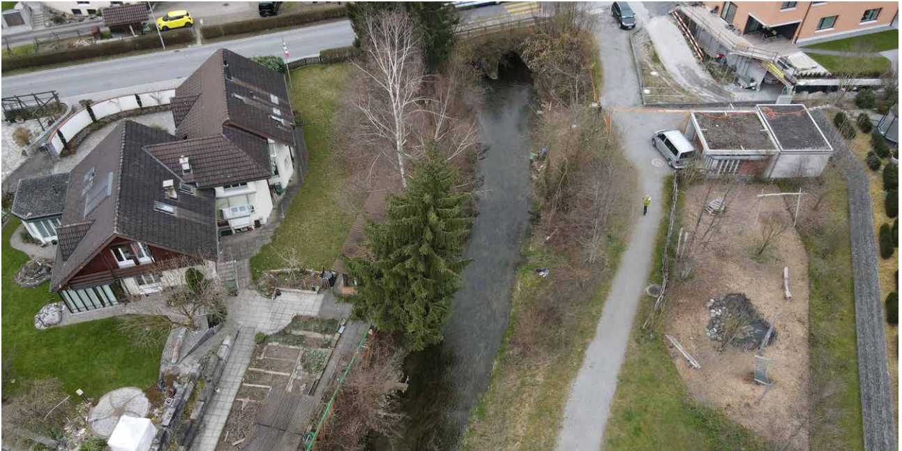
Restwasserstrecke der Unteren Lorze bei Hagedorn flussaufwärts betrachtet.
