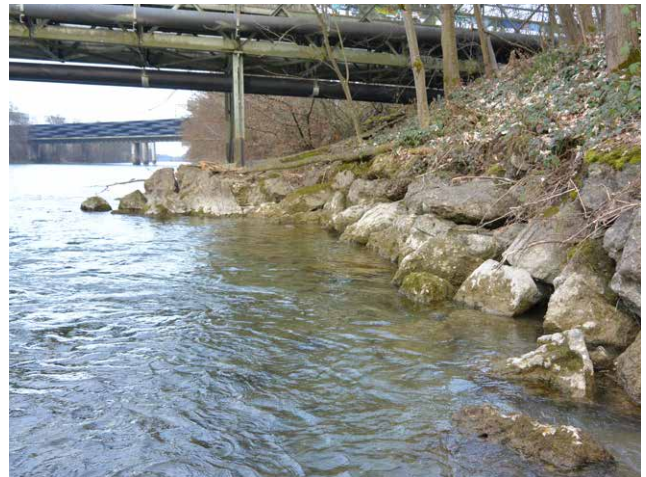
Sich teilweise auflösender, sehr grober Uferverbau am rechten Ufer. Flachwasserbereich ebenfalls mit grobem Substrat.
