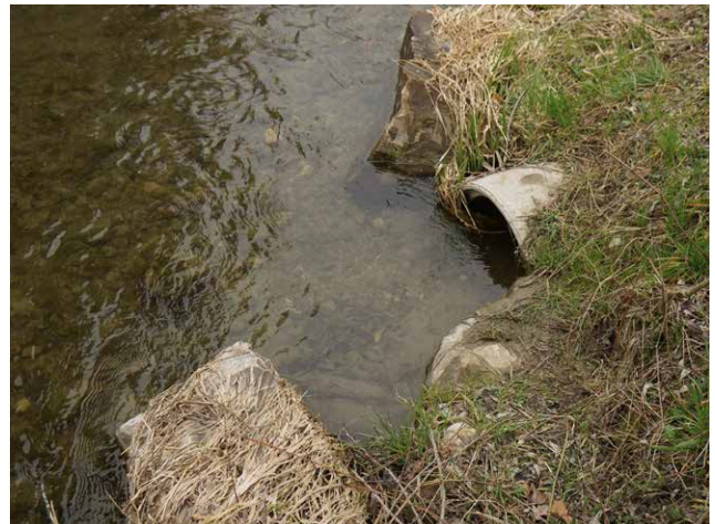
Zuleitung am rechten Ufer - vermutlich Regenwassereinleitung.
