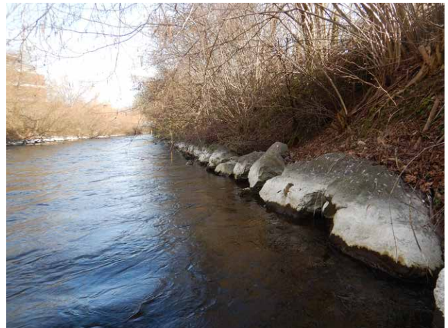
Mit grossen Blöcken befestigtes linkes Ufer.
