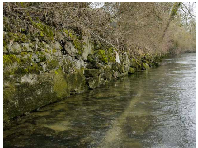
Über 2 m hohe Mauer und mit Blöcken befestigte Flachwasserterrasse am linken Ufer.
