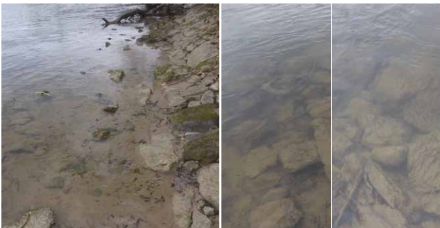
An den Uferverbau anschliessend Sims mit Blöcken und etwas Sand am linken Ufer.
