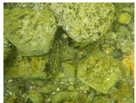
Grobsteinige, leicht verkrustete Sohle bei der rechtsseitigen Taucherprobe.
