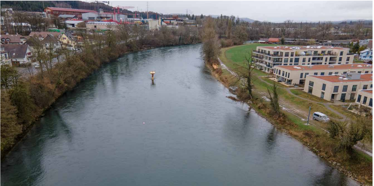
Mittelland-Reuss unterhalb der Wehranlage Bremgarten flussabwärts betrachtet.
