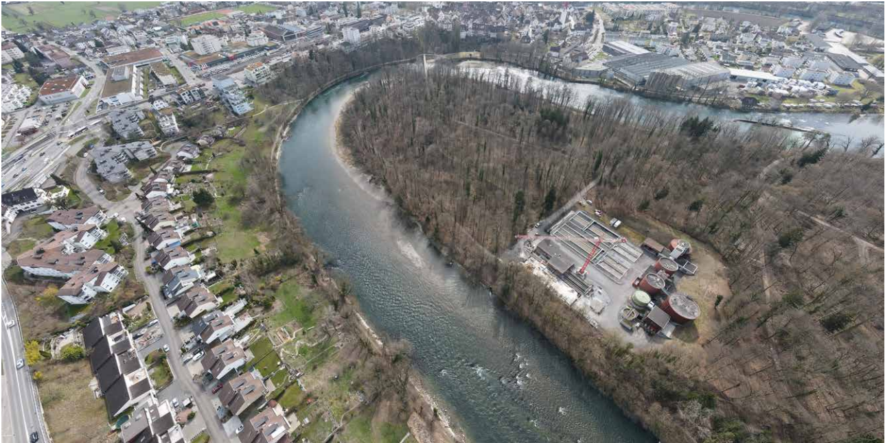
Mittelland-Reuss oberhalb der ARA Bremgarten flussaufwärts betrachtet.
