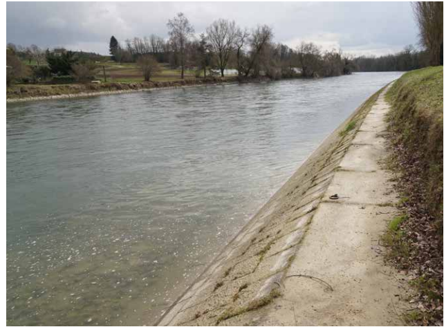
Fast fugenloser Uferverbau über einen grossen Teil des linken Ufers; Flachwasserbereich durch Vorschüttung strömungsreduziert.
