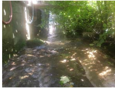
Blick auf die Gewässersohle
