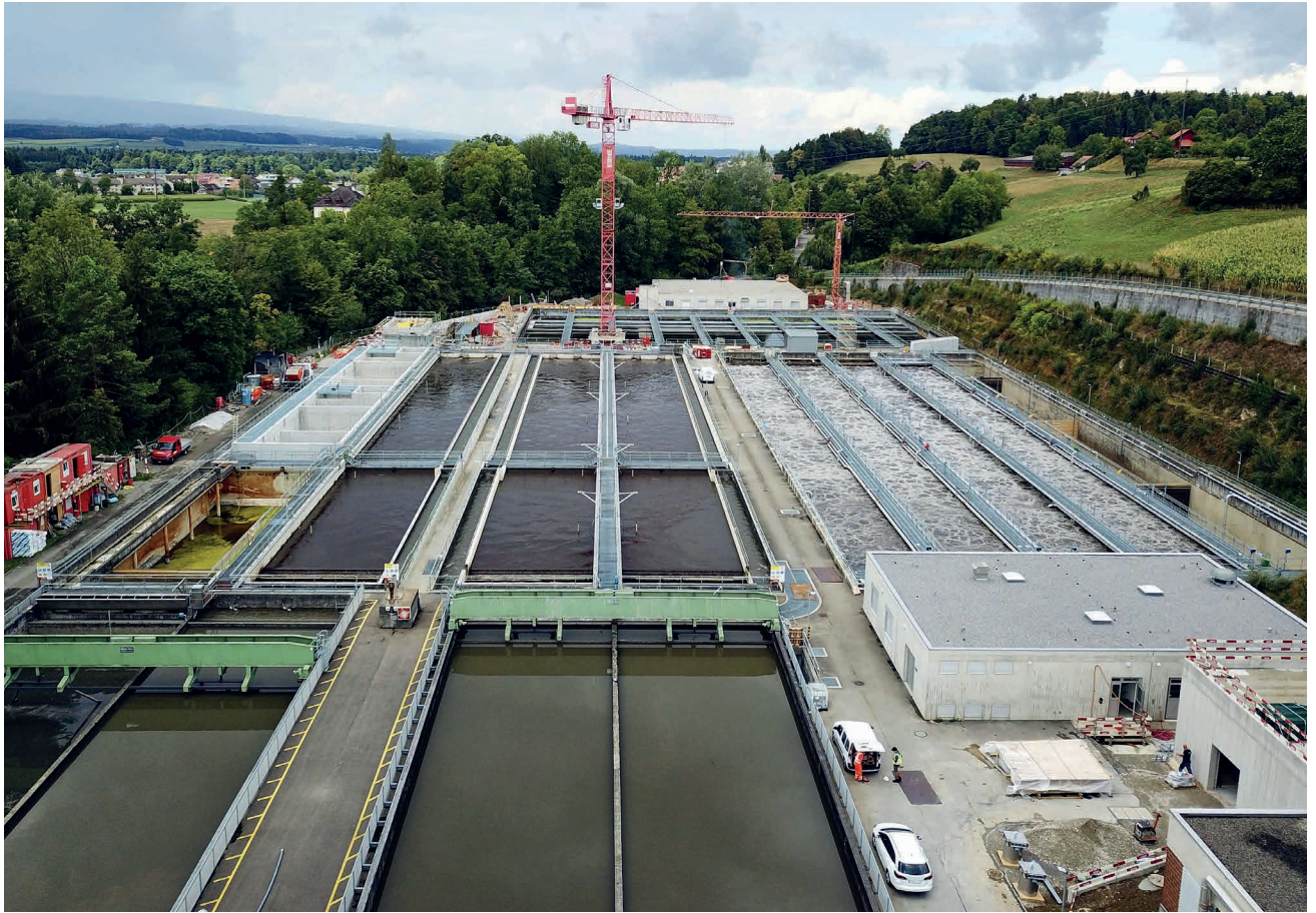
Der Bau der 4. Reinigungsstufe in der ARA Schönau: Erstellung des Kontaktbeckens, das dem Sandfilter vorgeschaltet ist.
