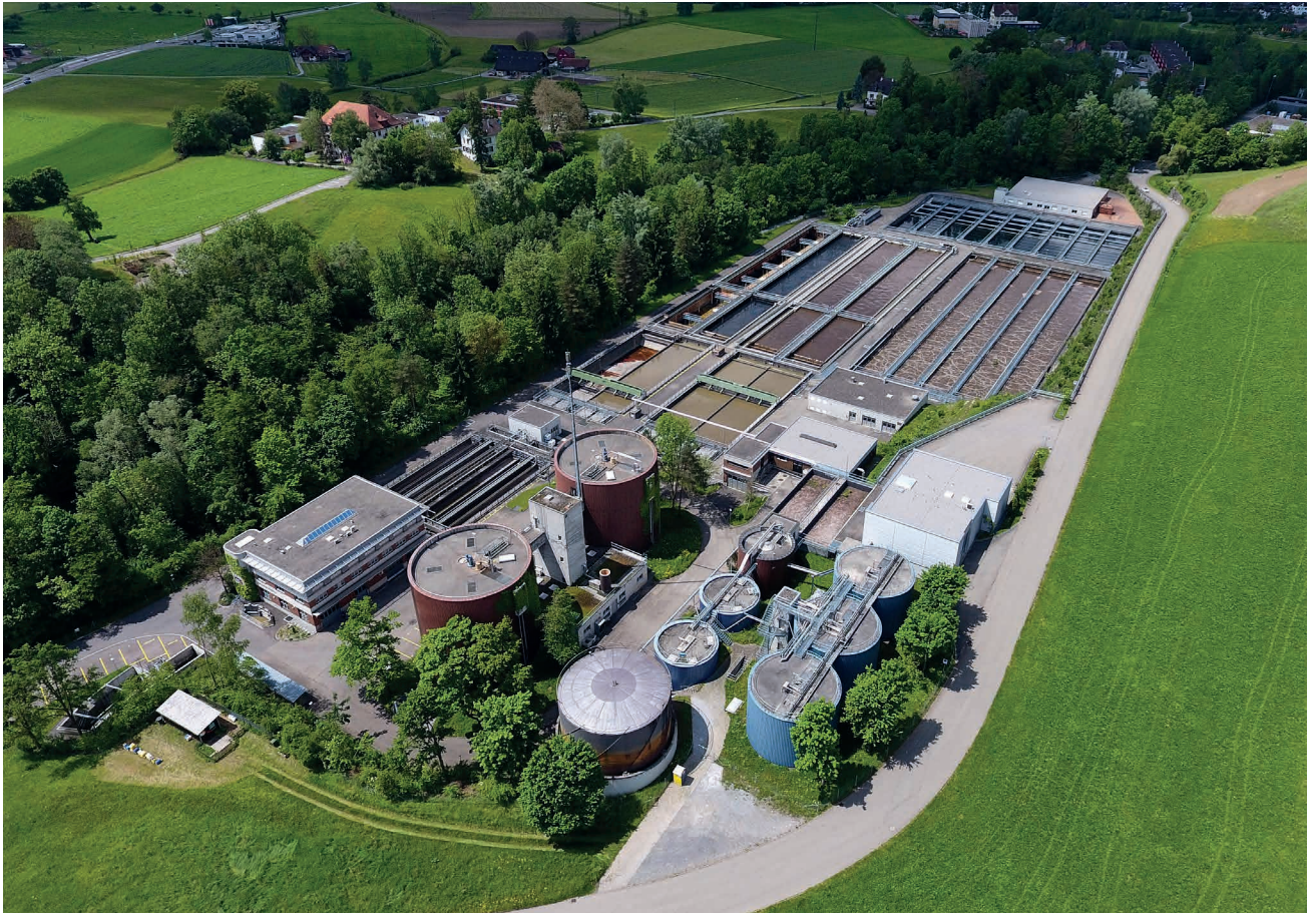
Mit über 150'000 angeschlossenen Einwohnern gehört die Kläranlage Schönau in Cham/Zug zu den grösseren Kläranlagen der Schweiz.
