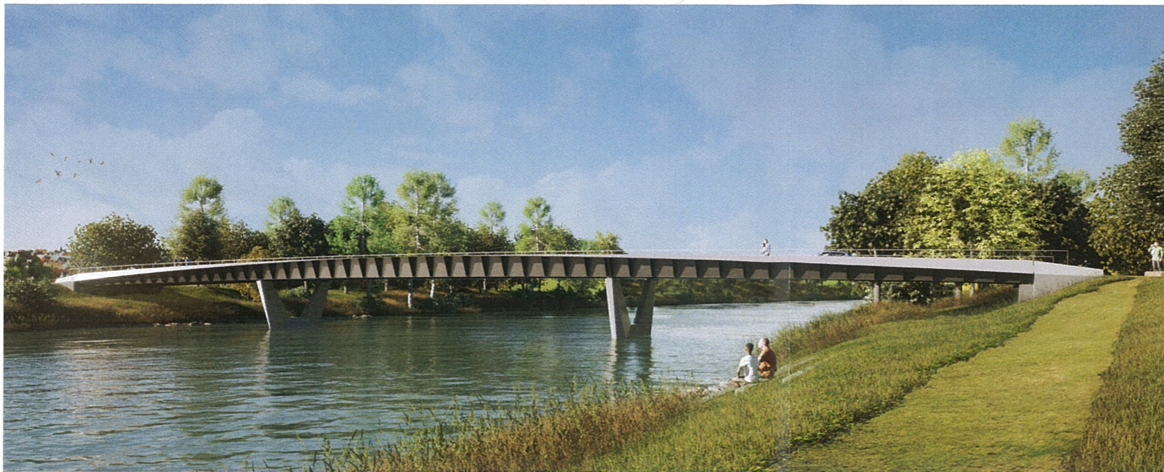
Blick vom südwestlichen Uferbereich
