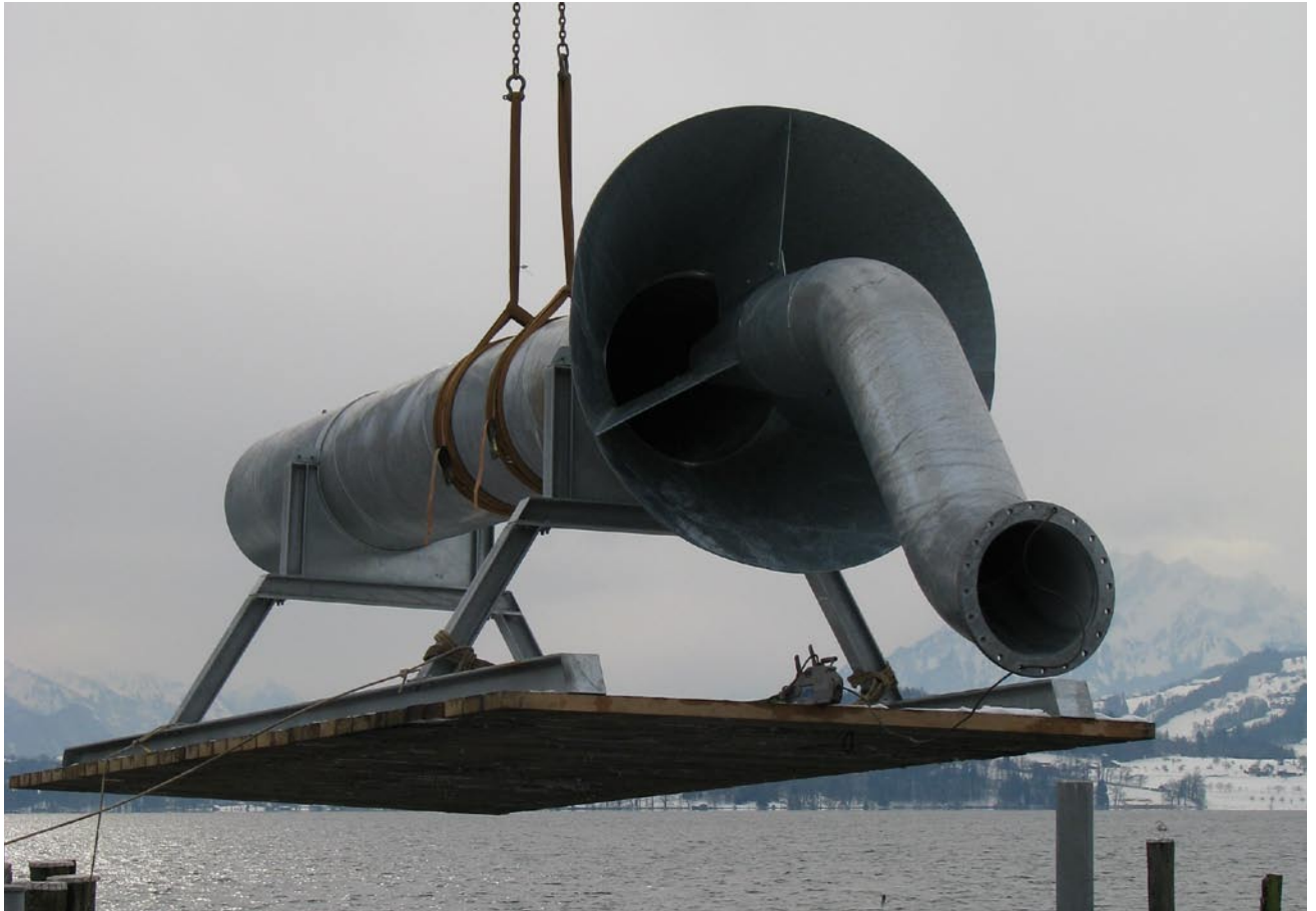
Kühlwasserrückgabe der Siemens Schweiz AG: Spektakuläre Wasserung des hydraulischen Mischers im Februar 2010 beim Bootshafen in Zug.
