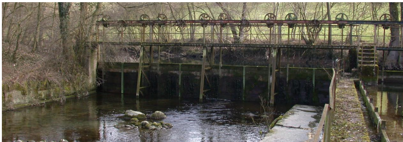
Vorhergehende Seite: Die neue Restwassereinleitung mit Fischaufstieg und Dotierwasserklappe vertet den Lebensraum in der Lorze massiv auf.
